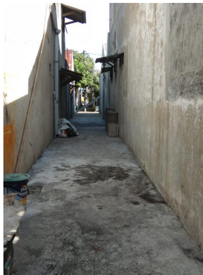
Gambar 5. Hasil akhir pekerjaan jalan brandgang (Sumber: Dokumentasi Kegiatan, 2021)
