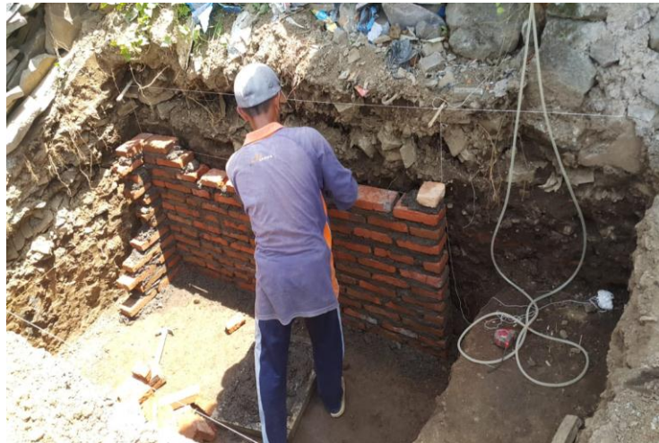
Gambar 4. Pembangunan Saluran Pembuangan Dan Penampungan Air (Sumber: Dokumentasi Lapangan, 2020)
