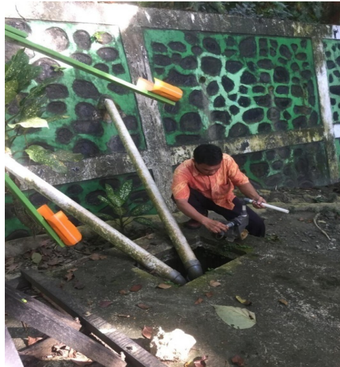
Gambar 3. Pemasangan Mesin Pompa Air (Sumber: Dokumentasi Lapangan, 2023)
