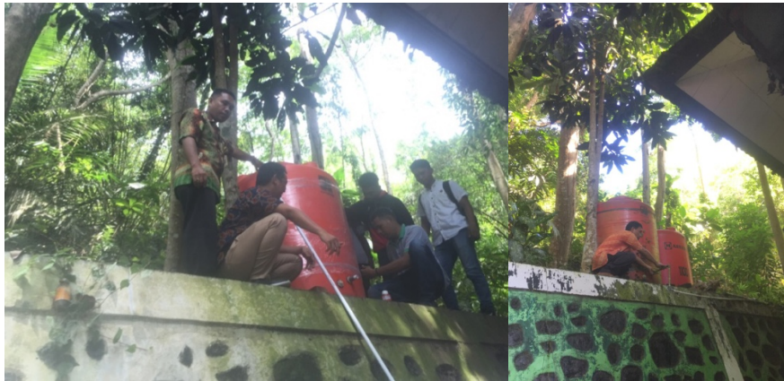
Gambar 4. Pemasangan Penampungan air (Sumber: Dokumentasi Lapangan, 2023)
